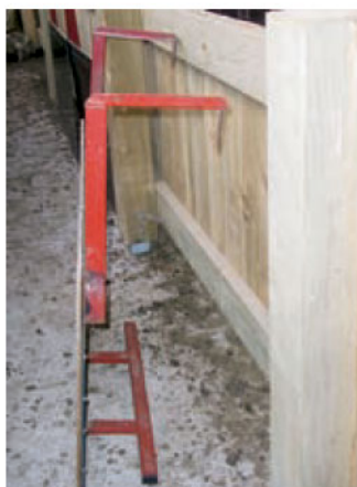
Des plaques avec fer en U sont accrochées à l'intérieur du couloir.
